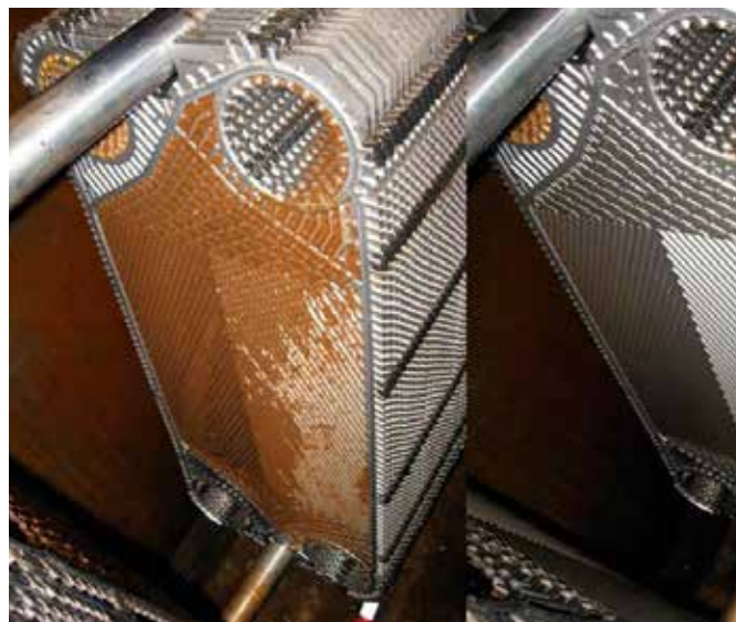
Пластинчатый теплообменник, забитый отложениями шлама
