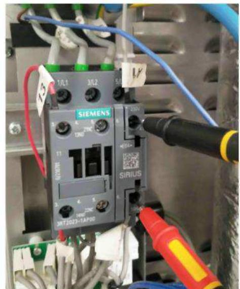
б- Проверьте, нет ли деформации или отсутствия контакта в фазном и нулевом кабелях резистора, по которым не протекает ток, отключив входное электропитание устройства.
