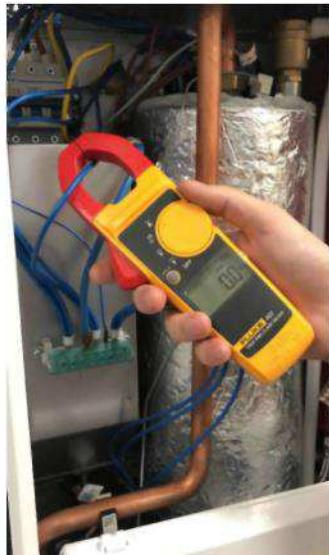
а- Откройте защитную крышку солевой группы и проверьте наличие напряжения на выходных контактах 2,4 и 6 контактора с помощью контрольной ручки. Если между клеммами A1-A2 контактора измерена разница напряжений между 180-240 В переменного тока, замените контактор, если на любом из трех контактов нет напряжения, хотя на входных полюсах контактора есть энергия.
